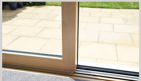
Ob offen oder geschlossen, der Mittelposten fluchtet immer mit den vertikalen Flügelprofilen, für einen nahtlosen Übergang zwischen Drinnen und Draußen.
